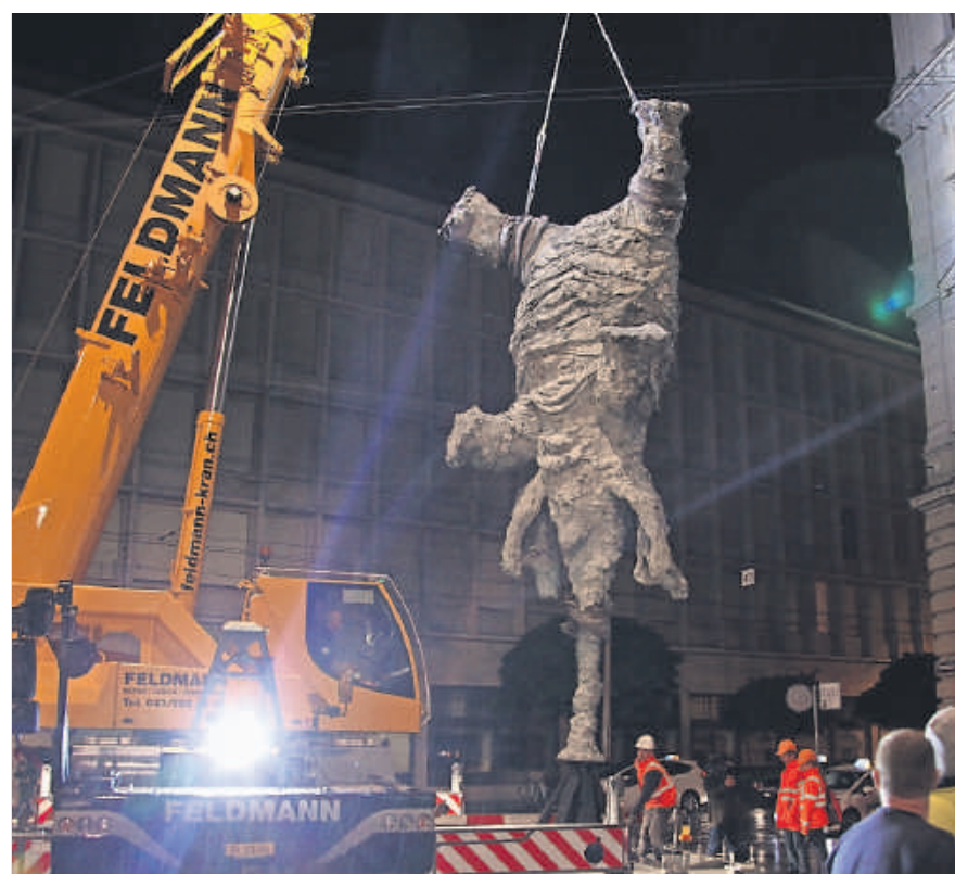
Mit einem grossen Kran wurde der 7000 kg schwere Koloss platziert.
